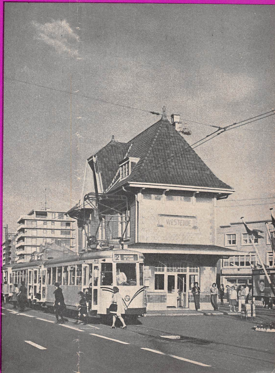
L'arrêt du tram à Westende, sur la ligne vicinale Ostende - La Panne.
